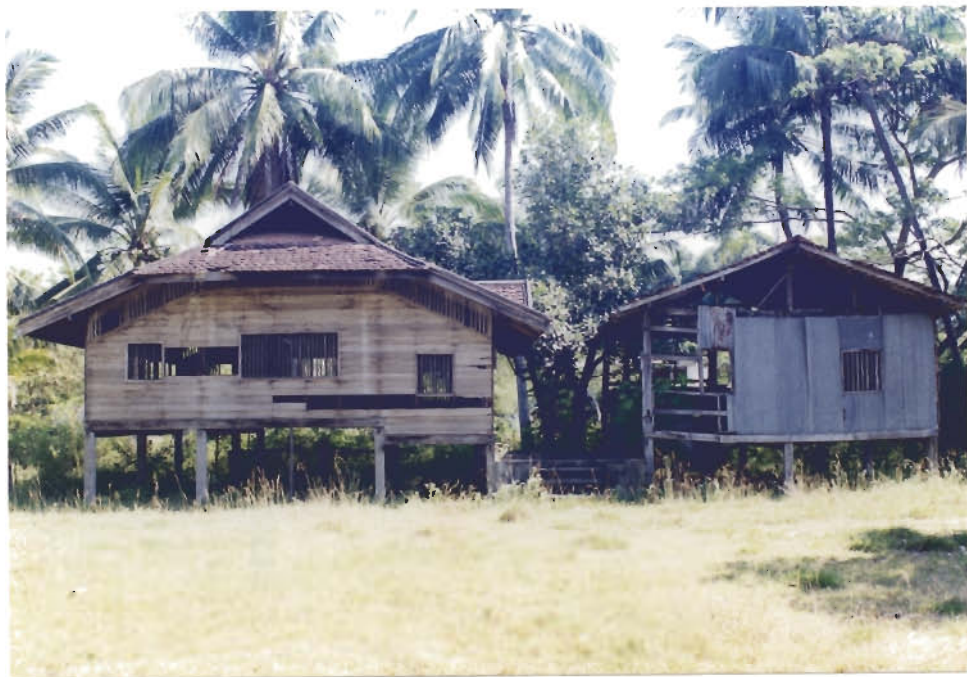
สร้างด้วยไม้เนื้อแข็งชั้นเดียว ยกพื้น กว้าง ๘ เมตร ยาว ๑๐ เมตร
